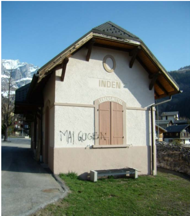
Vandalismusakt am "Dorflädeli"
