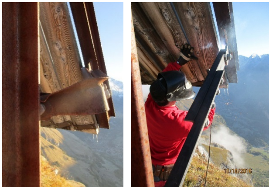
Verschraubungen und Verbindungen wurden repariert
