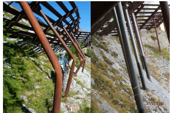
Stützen von Stahlschneebrücken wurden erneuert
