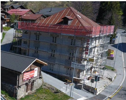
Der Umbau am Hotel des Alpes hat begonnen
