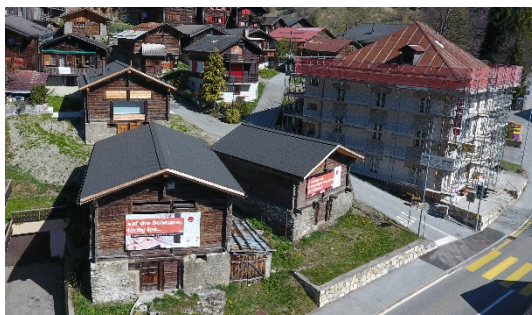
Gebäude 2a+b werden umgebaut, hinten Gebäude 1
