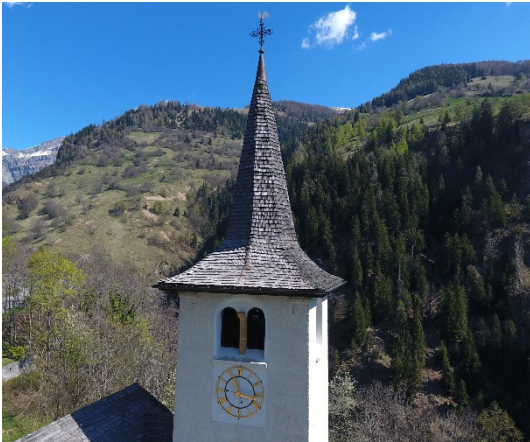
Der Kettenzug im Kirchturm wurde ausgetauscht
