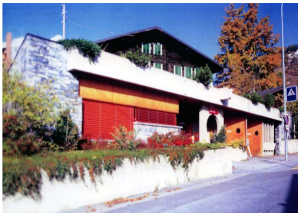
Mehrzweckgebäude mit Gemeindebüro und Poststelle in Inden
