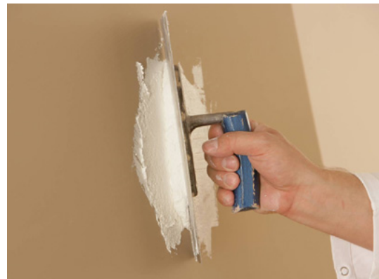
Wand mit Kalk verputzen (Kalkmörtel)
