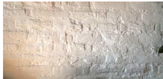
Wand mit Kalkmilch gestrichen
