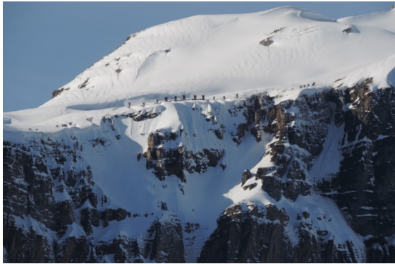
Schutzbauten oberhalb Inden
