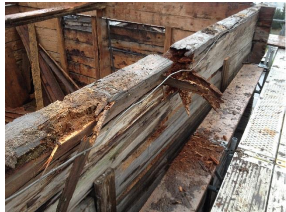
Morsches Holz musste ersetzt werden
