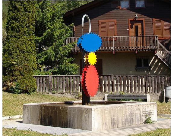
Der Dorfbrunnen von Inden soll saniert werden
