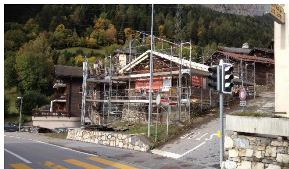
Sanierungsarbeiten an den Projekten 2a+b
