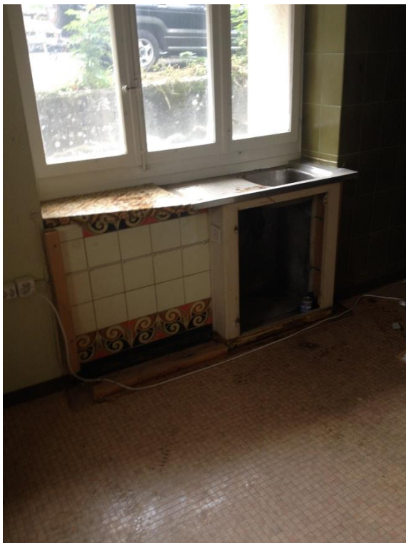
Die alte Küche war renovationsbedürftig
