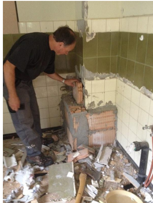
Kurt Plaschy bei den Renovationsarbeiten
