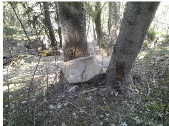
Schneedruck- und Erosionsschäden werden behoben.
