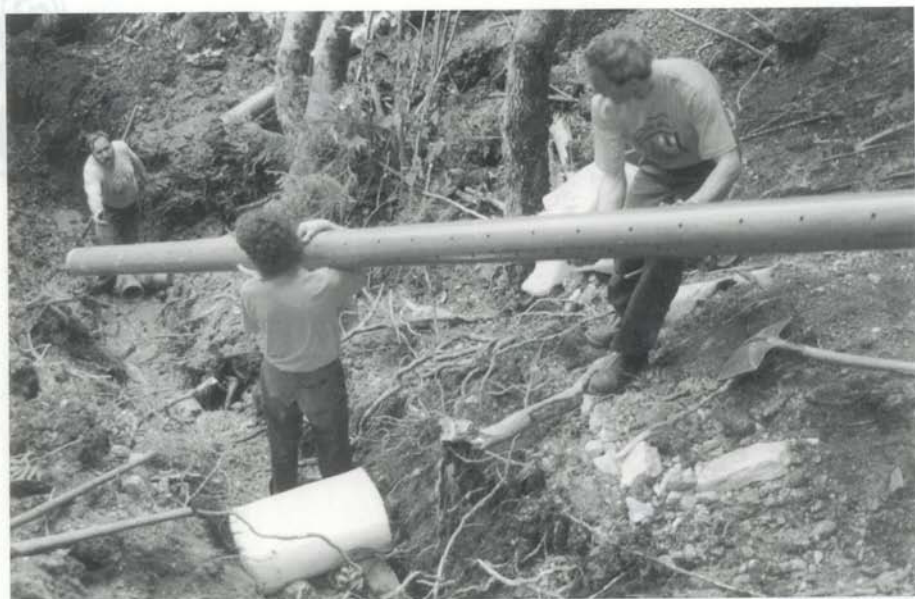
Der Zivilschutz Basel bei der Arbeit im "Sevetustutz" (Rumelingweg)
