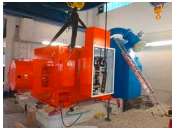
Lieferung und Montage des neuen Generators
