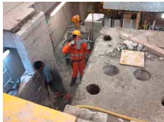
Erstellung Fundament für Maschinengruppe 2
