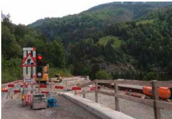
Ausbauarbeiten im Jahr 2013 in Rumeling
