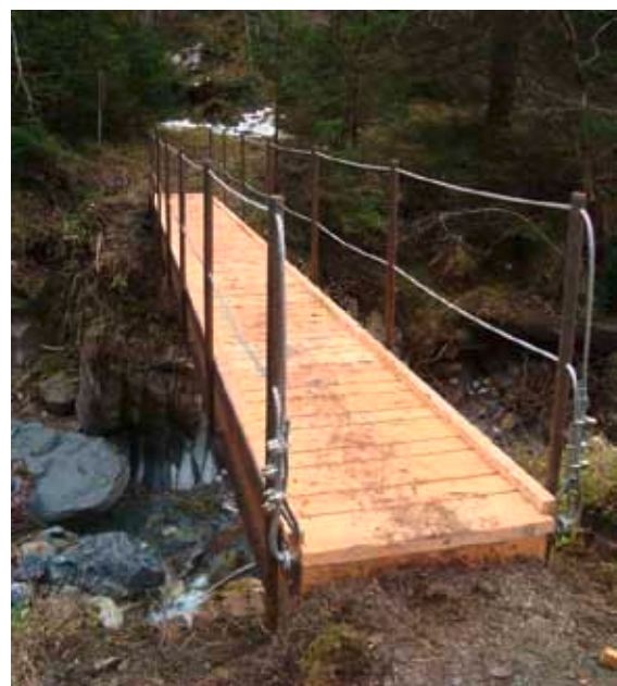
Neue Brücke im Tscholiwald - Übergang Dorbu
