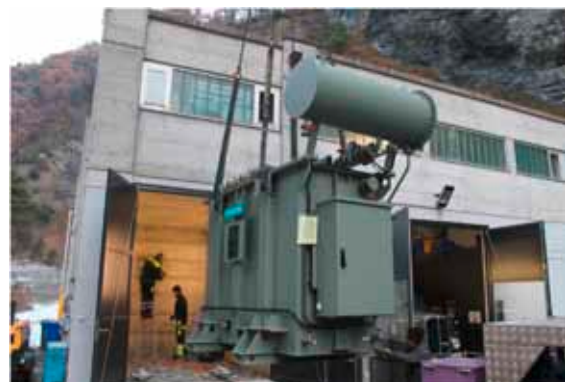
Lieferung und Montage des neuen Transformators
