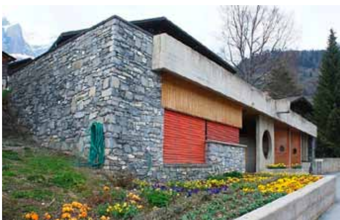
Mehrzweckgebäude mit Gemeindebüro und Poststelle in Inden
