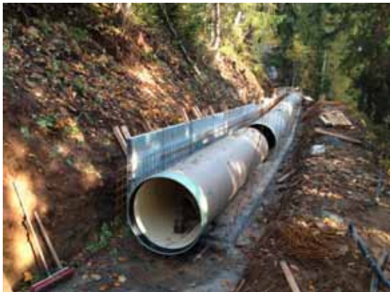
Neue GFK-Röhren werden verlegt (Bild 14.10.2012)
