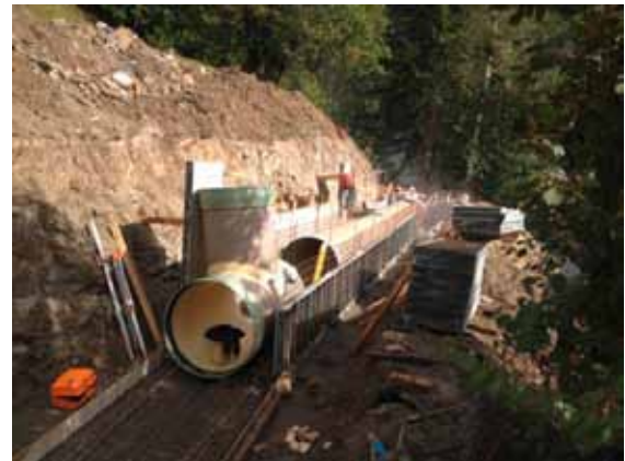
GFK-Röhre und GFK-Schacht (14.10.2012)
