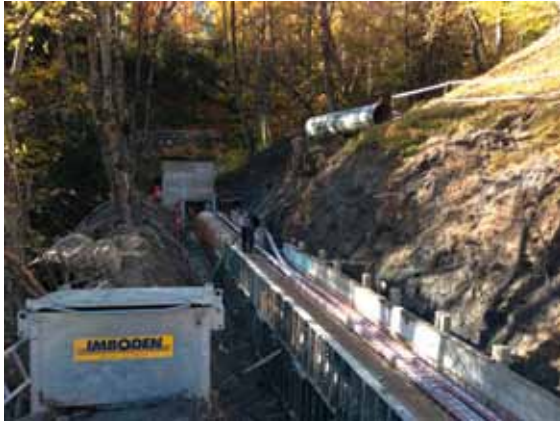
Abschlagsbauwerk/Hangleitung im Miliüt (25.10.2012)
