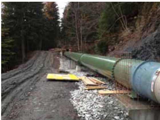
Ersatz der bestehenden Stahlleitungen (10.11.2012)
