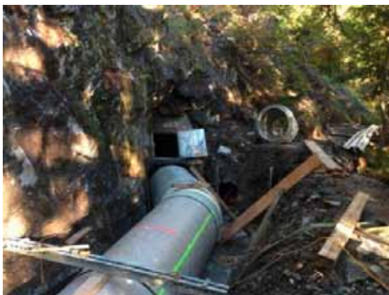
Übergang des Stollens auf die GFK-Rohre (14.10.2012)
