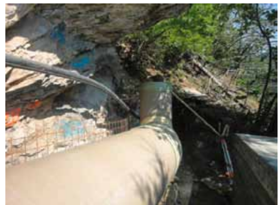
GFK-Übergang Stollen zu Schacht (04.09.2012)
