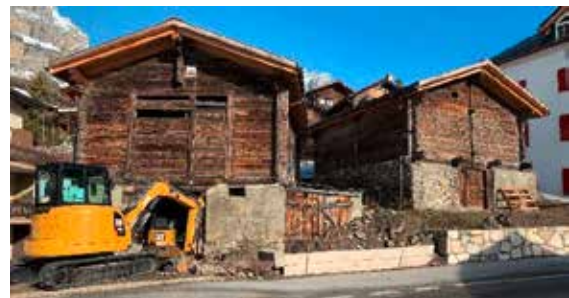
Bauarbeiten am künftigen Heim der Fam. Koop
