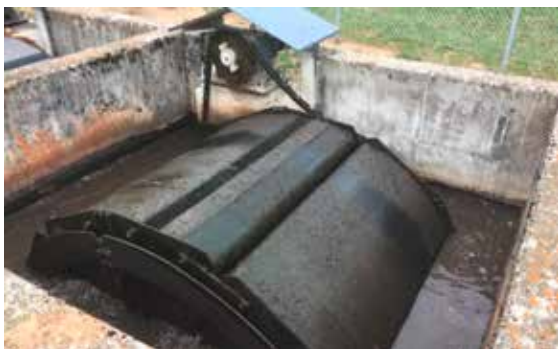
Rückschlammpumpe ARA Inden
