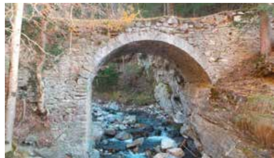
Pneudeponie bei der erst kürzlich sanierten Brücke
